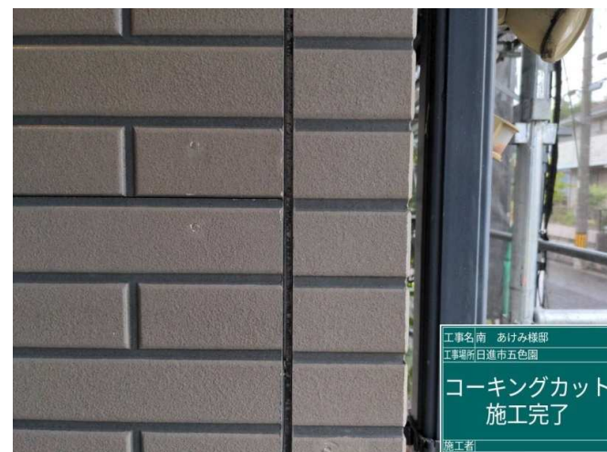
10 既設コーキングカット 施工完了
