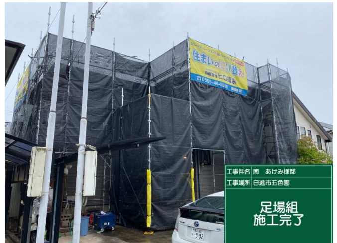
4 足場組 施工完了
