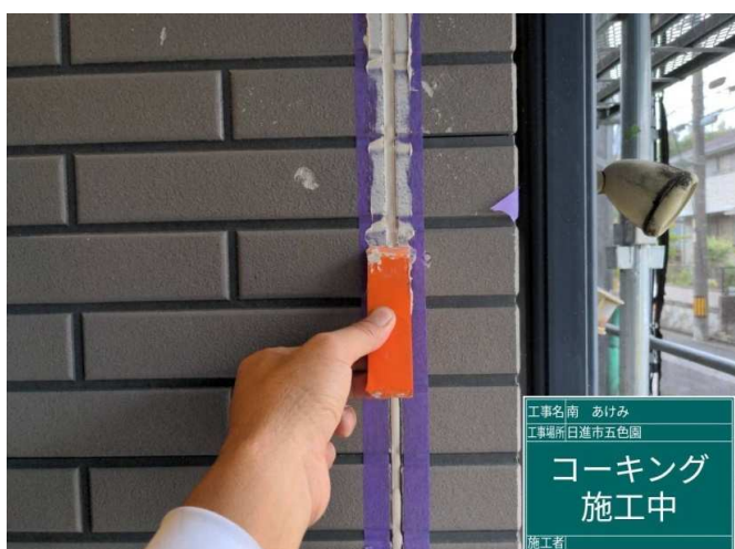
11 コーキング 施工中
