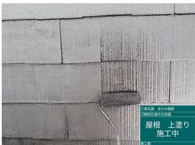
27 屋根 上塗り 施工中
