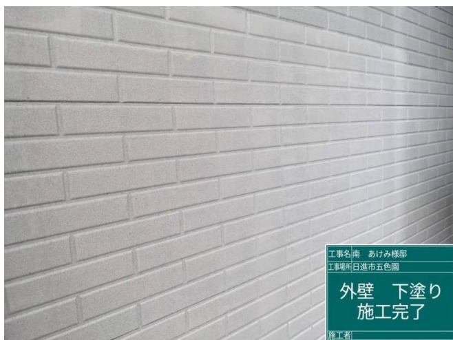
18 外壁 下塗り 施工完了
