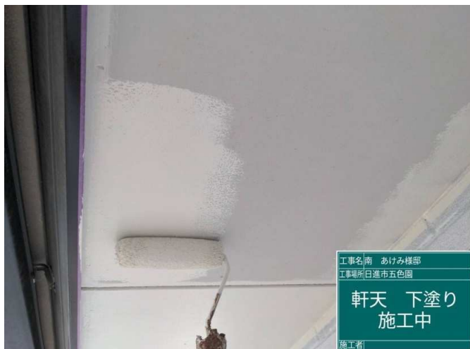
13 軒天 下塗り 施工中
