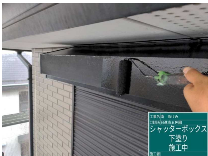
35 シャッター-BOX 下塗り 施工中
