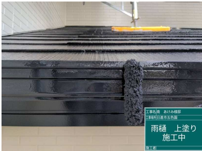
43 雨樋 上塗り 施工中
