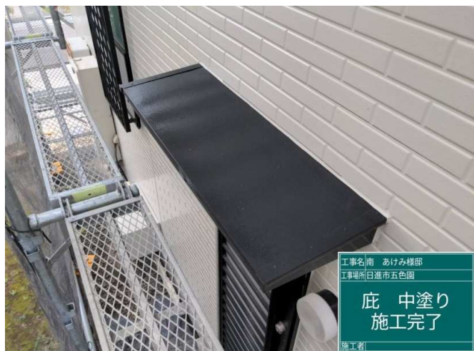
32 庇 中塗り 施工完了
