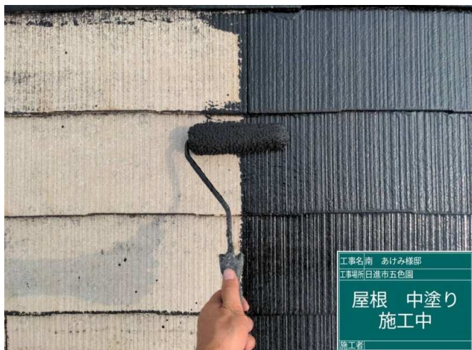
25 屋根 中塗り 施工中
