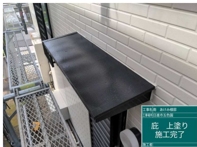
34 庇 上塗り 施工完了
