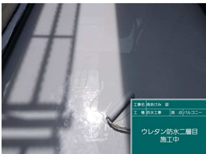
53 ウレタン防水 2層目 施工中
