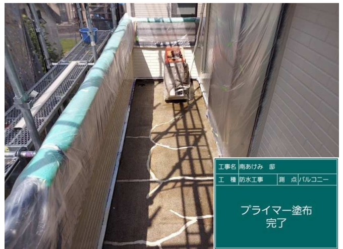
46 防水 プライマー 施工完了
