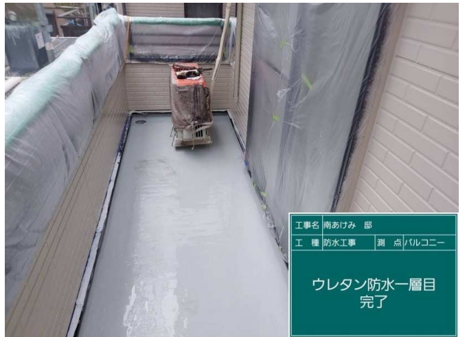
52 ウレタン防水 1層目 施工完了
