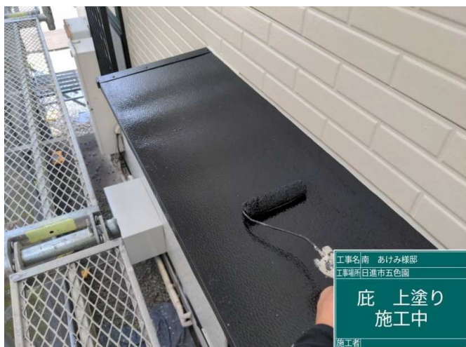
33 庇 上塗り 施工中
