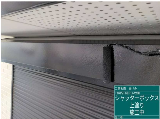
39 シャッターBOX 上塗り 施工中
