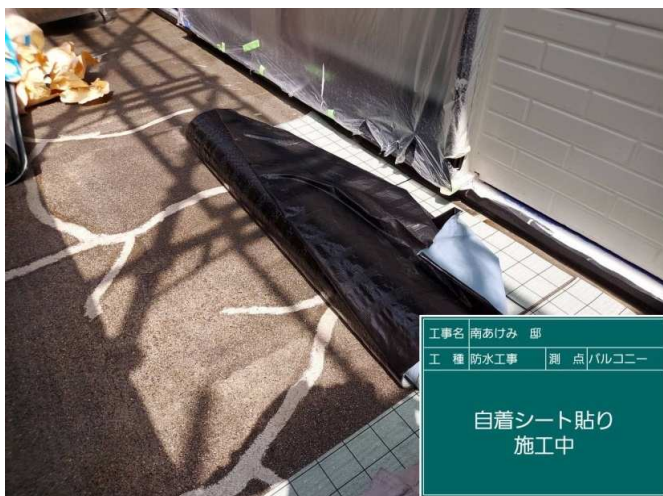
47 自着シート貼り 施工中
