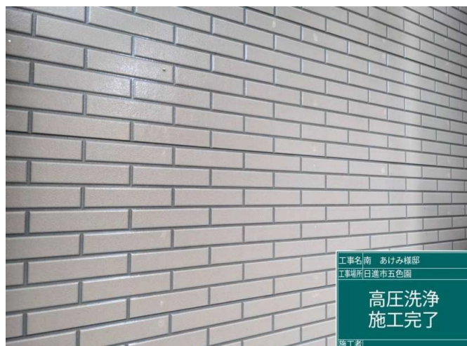
8 外壁 高圧洗浄 施工完了
