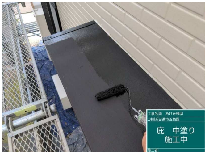
31 庇 中塗り 施工中
