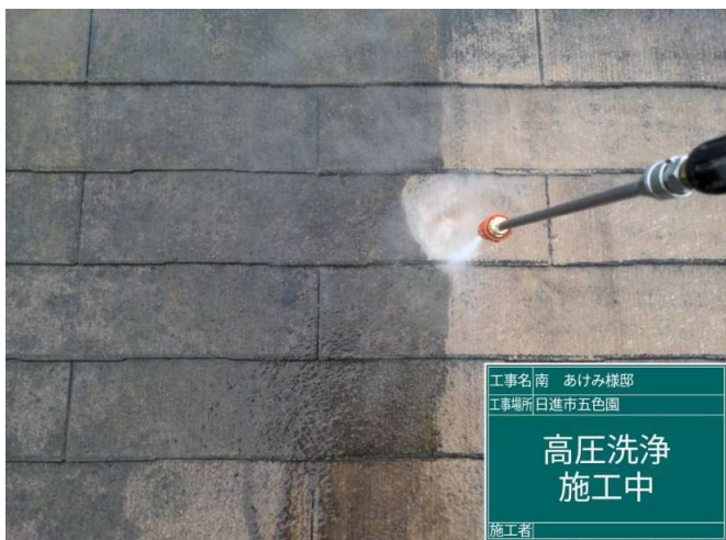
5 屋根 高圧洗浄 施工中
