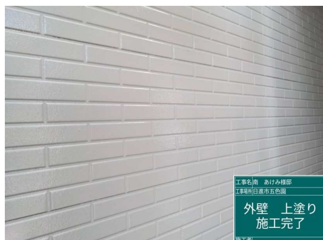
22 外壁 上塗り 施工完了
