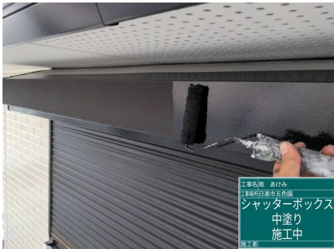
37 シャッターBOX 中塗り 施工中
