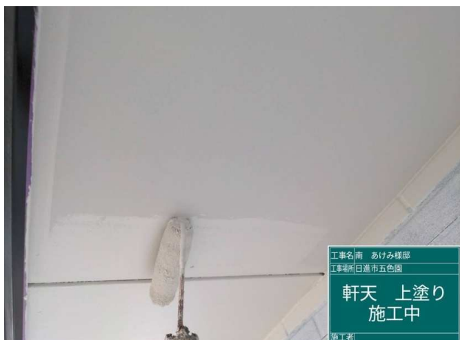
15 軒天 上塗り 施工中
