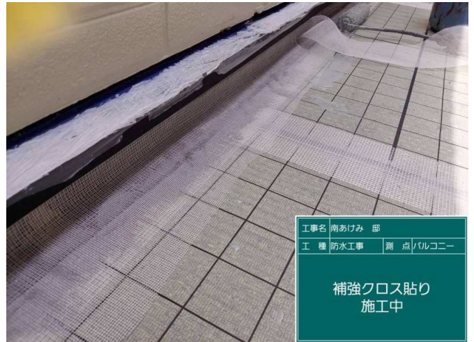
50 補強クロス貼り 施工中
