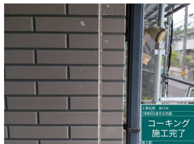
12 コーキング 施工完了
