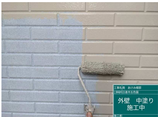
19 外壁 中塗り 施工中
