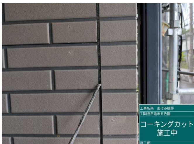
9 既設コーキングカット 施工中
