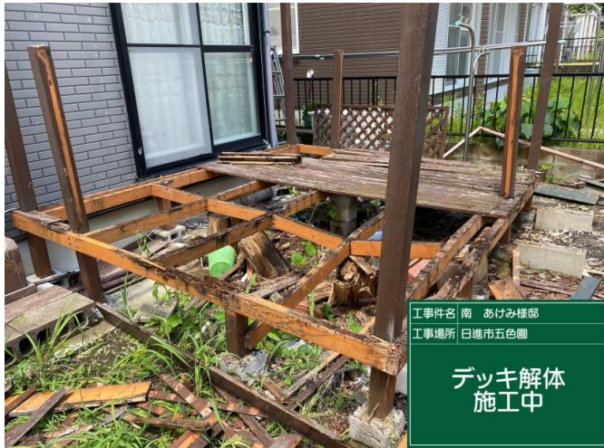
1 デッキ解体 施工中
