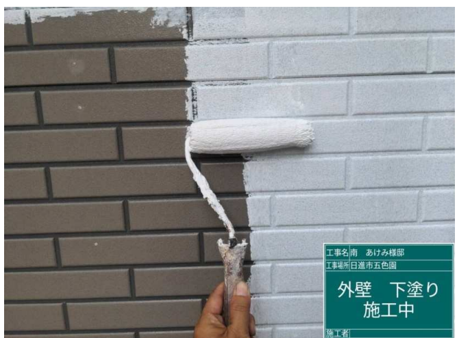
17 外壁 下塗り 施工中
