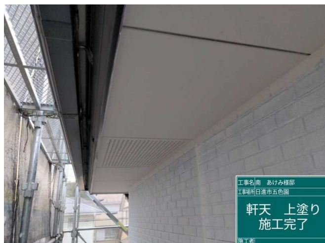
16 軒天 上塗り 施工完了
