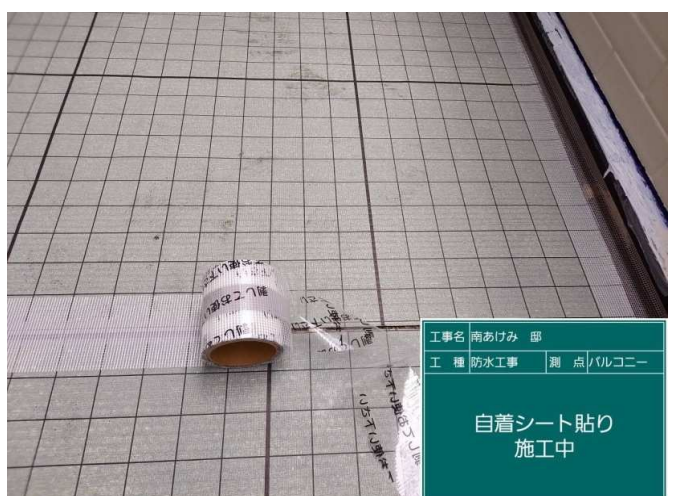
48 自着シート貼り 施工中
