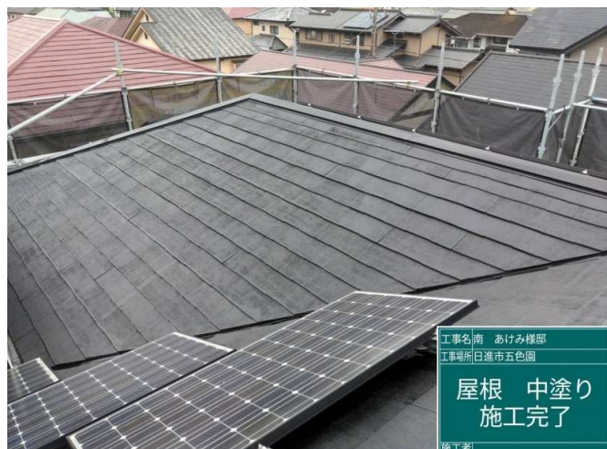
26 屋根 中塗り 施工完了
