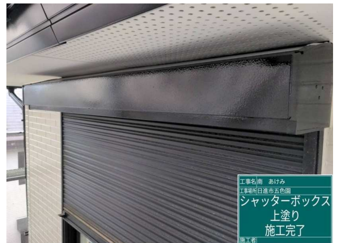
40 シャッターBOX 上塗り 施工完了
