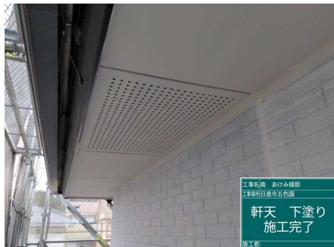
14 軒天 下塗り 施工完了
