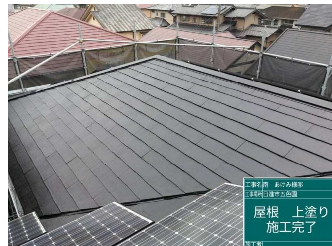
28 屋根 上塗り 施工完了
