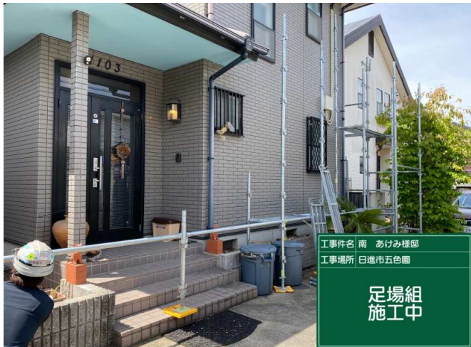
3 足場組 施工中
