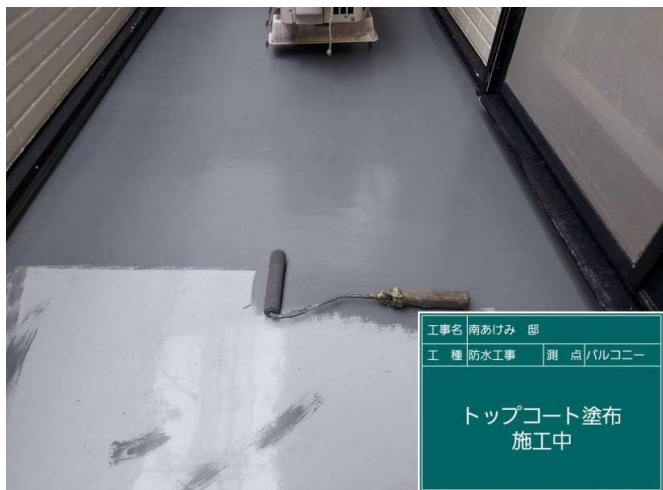
55 トップコート 施工中
