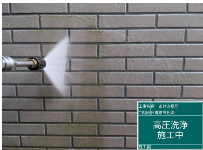
7 外壁 高圧洗浄 施工中
