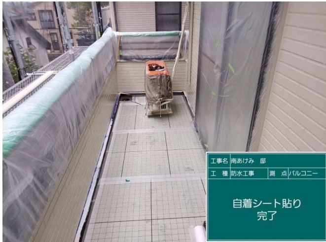
49 自着シート貼り 施工完了
