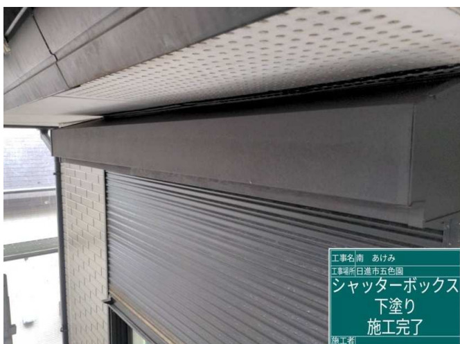
36 シャッター-BOX 下塗り 施工完了
