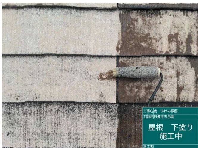
23 屋根 下塗り 施工中
