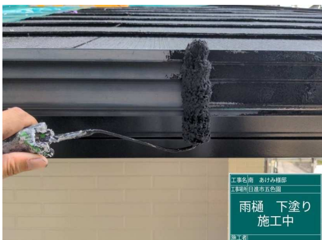
41 雨樋 下塗り 施工中
