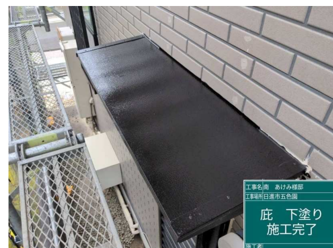
30 庇 下塗り 施工完了
