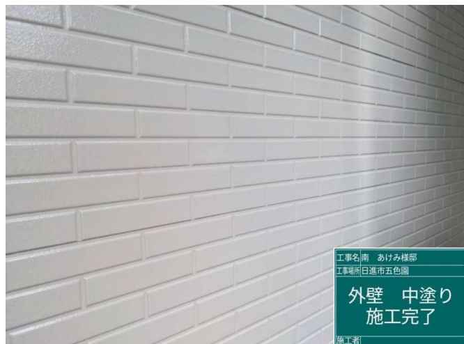
20 外壁 中塗り 施工完了
