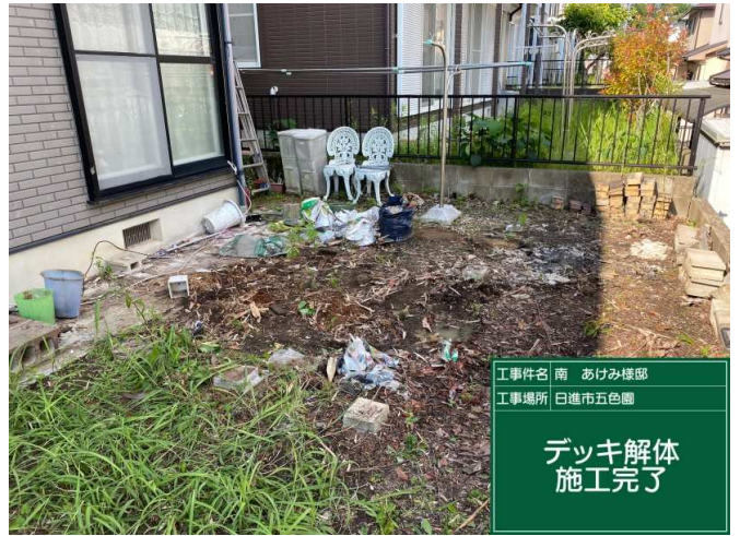
2 デッキ解体 施工完了
