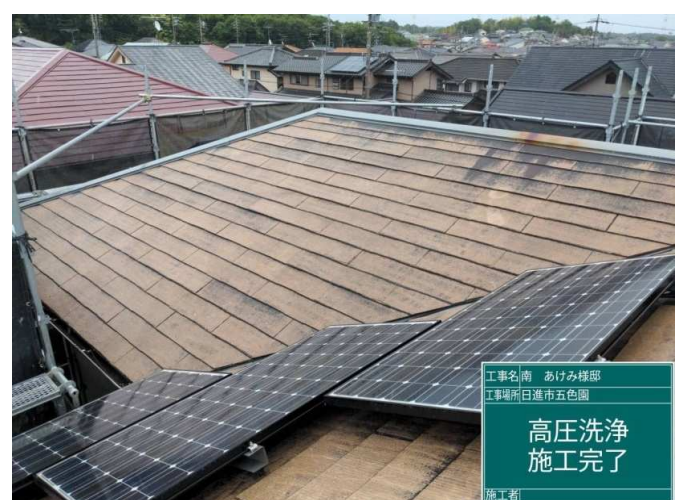
6 屋根 高圧洗浄 施工完了
