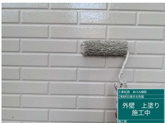
21 外壁 上塗り 施工中
