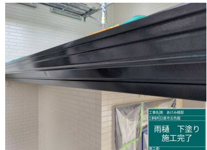
42 雨樋 下塗り 施工完了
