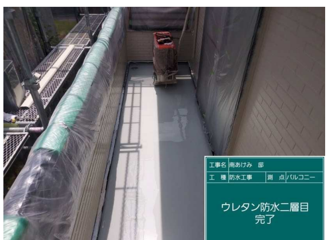
54 ウレタン防水 2層目 施工完了
