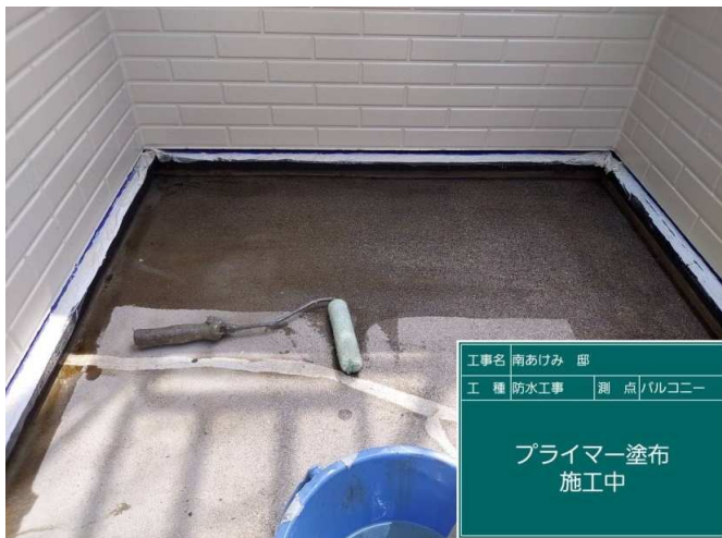
45 防水 プライマー 施工中
