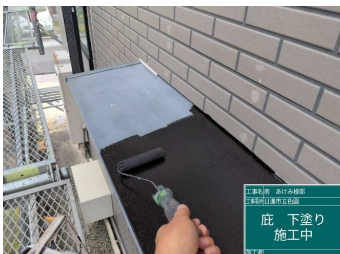
29 庇 下塗り 施工中
