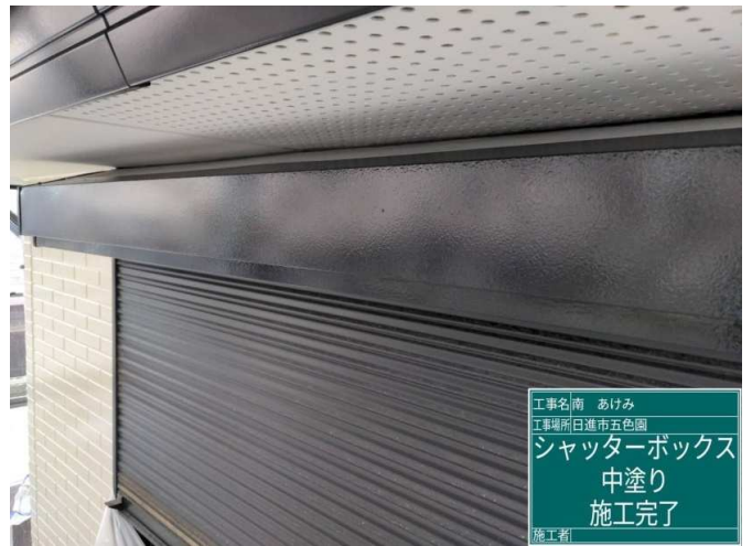
38 シャッターBOX 中塗り 施工完了
